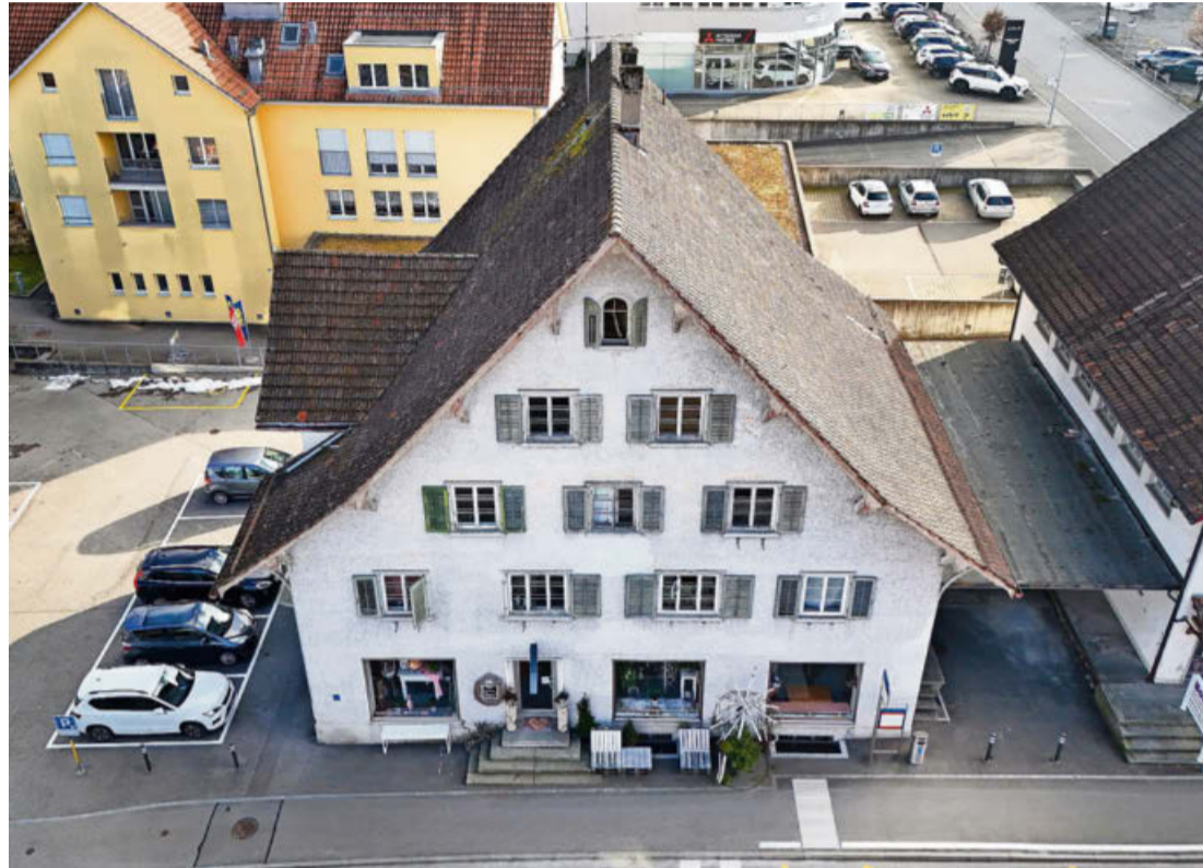
Das Haus des Anstosses: das Landihaus an der Usterstrasse 23 in Illnau. Foto: Simon Grässle
